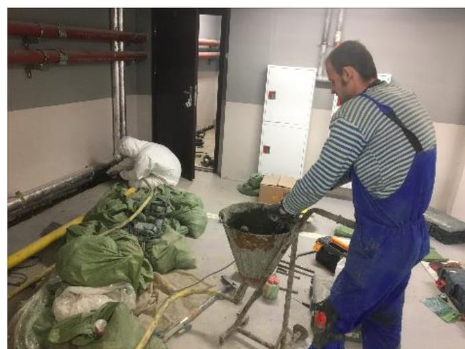
Гидроизоляция ОПТИМУМ ПРАЙС ГИДРО использовалась для инъектирования обводнённых холодных швов примыкания, вводов коммуникаций, восстановления и усиления бетонных конструкций стен, полов, колонн.
